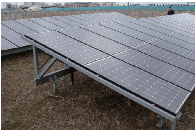
風荷重負荷の軽減を考慮したパネルの設置
