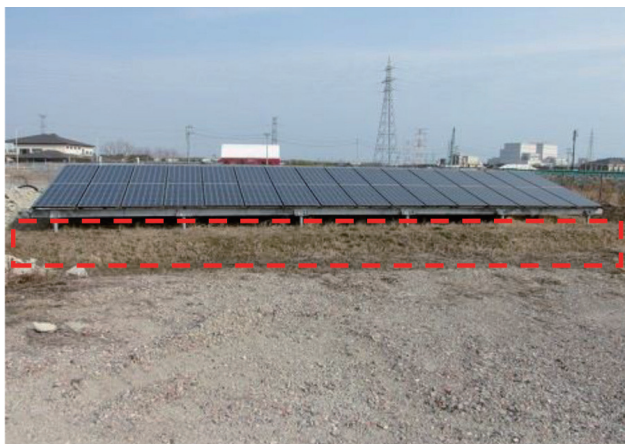
廃棄物層への影響を回避するため最終覆土層上部に約50cmを盛土
