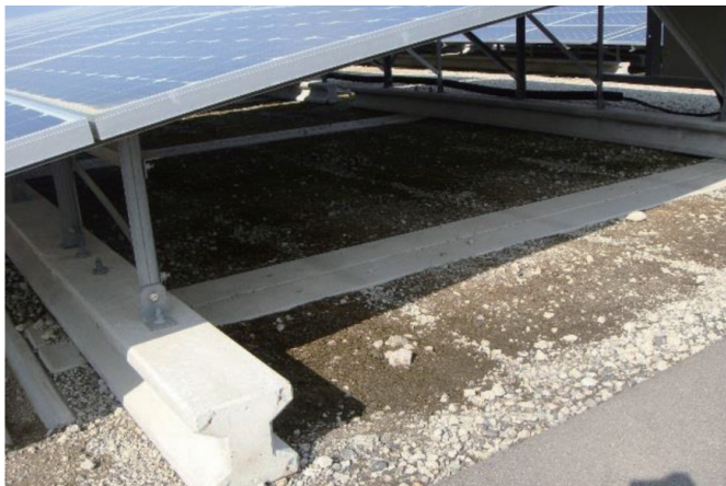
基礎部に井桁工法を採用することにより、不等沈下から発生するひずみによるパネル破損を防止
