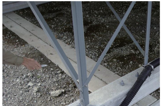
架台部には錆びにくく強度のあるZAM材(亜鉛・アルミニウム・マグネシウムの合金)を塗装
