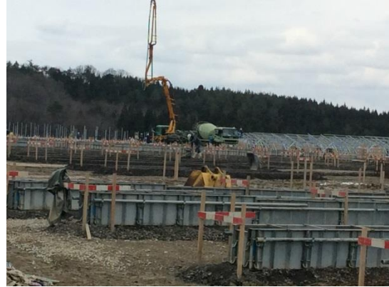
写真7.2-8基礎工（整地と型枠工）
