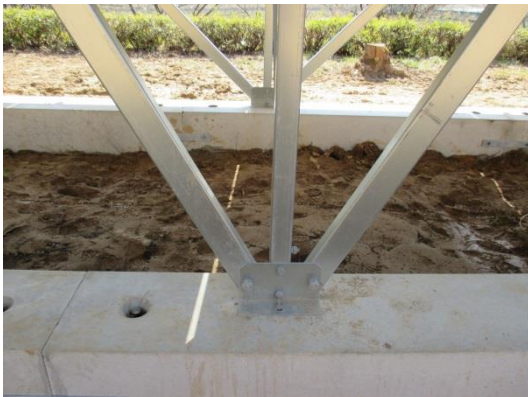
写真7.2-37 基礎・架台その4
