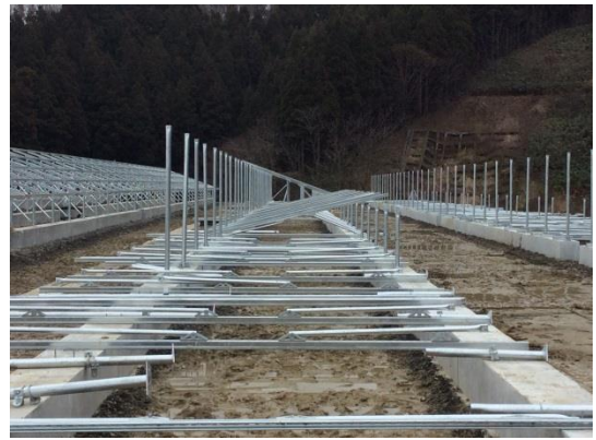
写真7.2-10 架台工（支柱建方）
