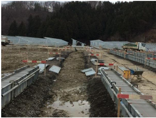
写真7.2-9 基礎工（コンクリ打設）
