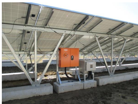
写真7.2-42 非常用コンセント
