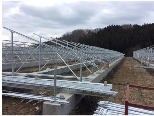
写真7.2-14架台（レール設置）
