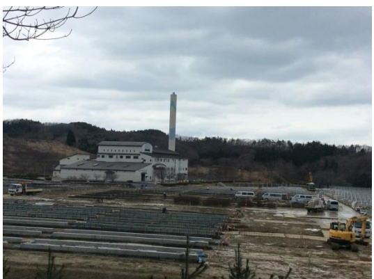
写真7.2-5基礎施工状況（南側より）
