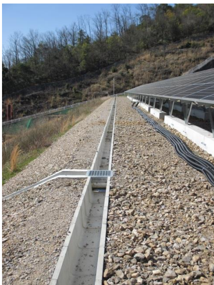
写真7.2-39 処分場排水側溝
