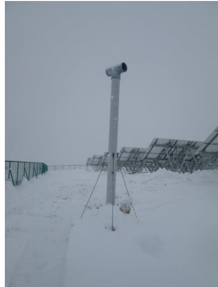
写真 7.2-28 ガス抜き管
