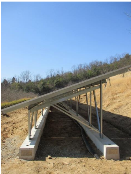
写真7.2-35基礎・架台その2
