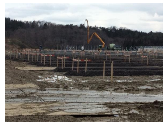
写真7.2-6 基礎工（整地工）
