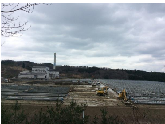
写真7.2-3全体施工状況（南側より）
