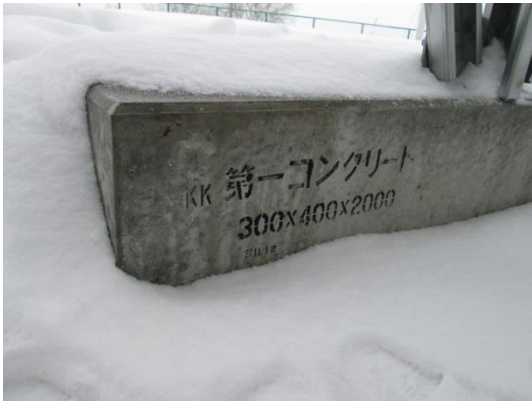
写真 7.2-25 架台基礎 2次製品
