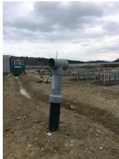
写真7.2-16ガス抜き管
