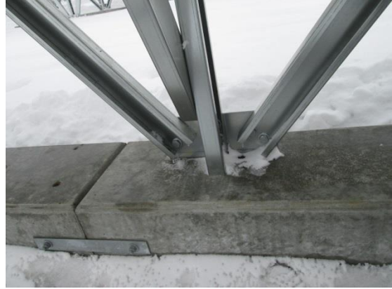
写真 7.2-24 架台基礎部分
