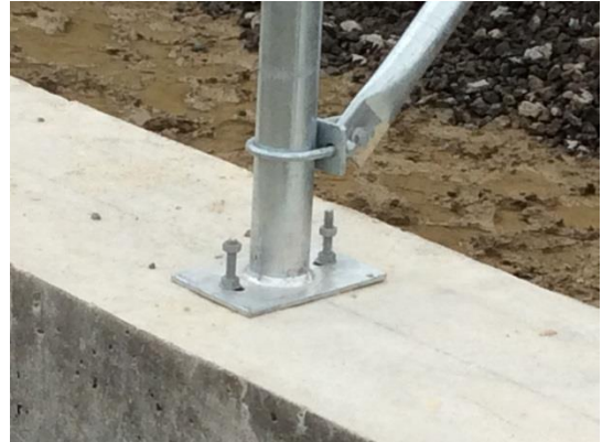
写真7.2-12架台（支柱基礎固定）
