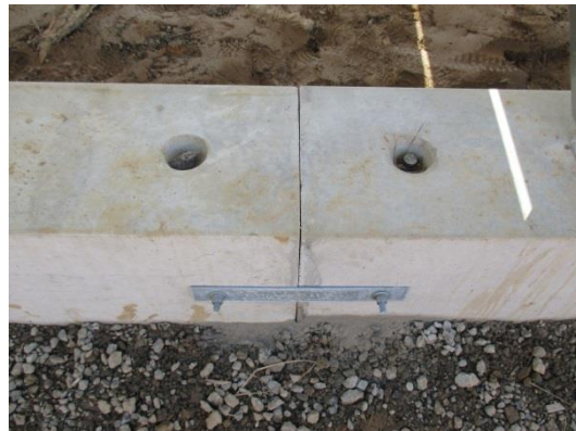
写真7.2-38 コンクリート基礎連結部
