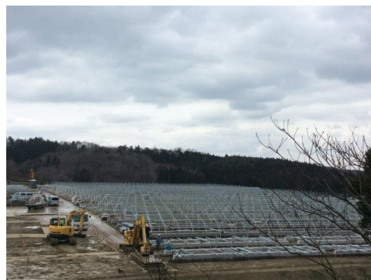
写真7.2-4架台施工状況（南側より）
