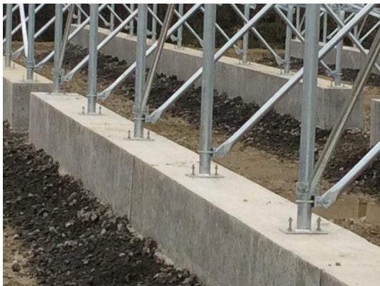
写真7.2-11架台（支柱）
