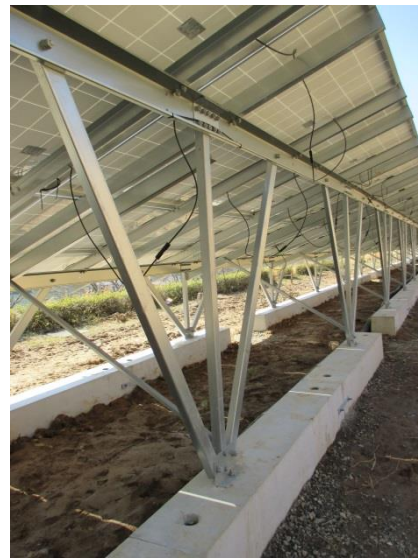
写真7.2-36基礎・架台その3
