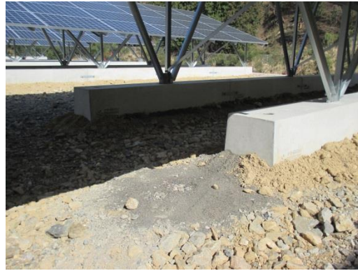
写真7.2-34基礎・架台その1
