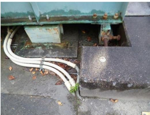
写真7.1-25 不等沈下観測のための基準点
