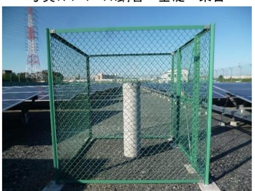
写真7.1-6 ガス抜き管
