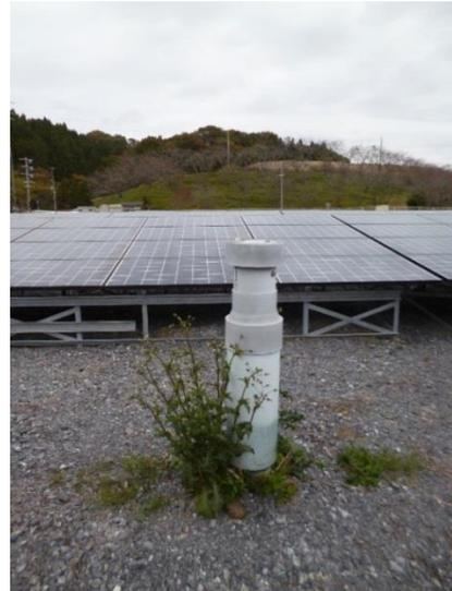
写真7.1-22 ガス抜き管
