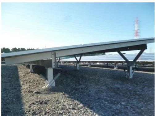
写真7.1-4 FX鋼管 基礎・架台
