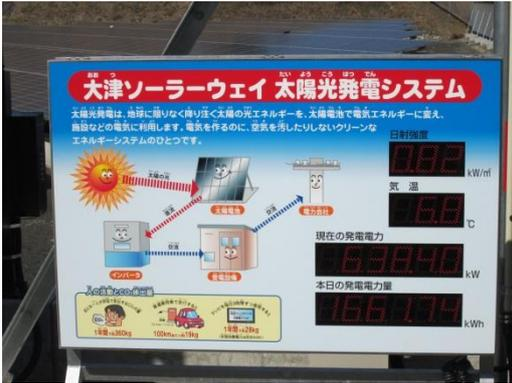
写真 7.1-50 発電状況表示盤
