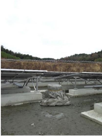
写真7.1-44 ガス抜き管
