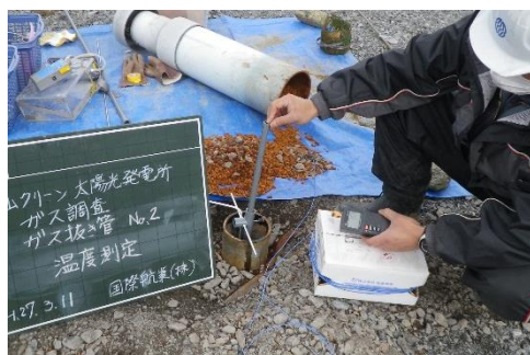
図 3.4-19 ガス抜き管(脱硫剤取外し後)
