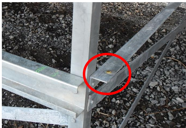
図 3.4-10 三山クリーン(株)産業廃棄物最終処分場における計測点の設置状況
