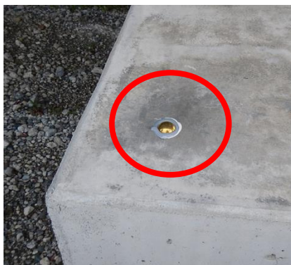
図 3.4-11 浜松市静ヶ谷最終処分場における計測点の設置状況
