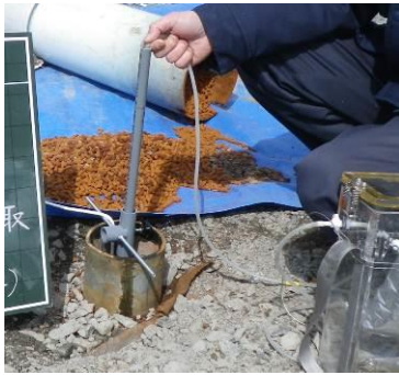
図 3.4-31 ガス抜き管内挿塩ビ管
