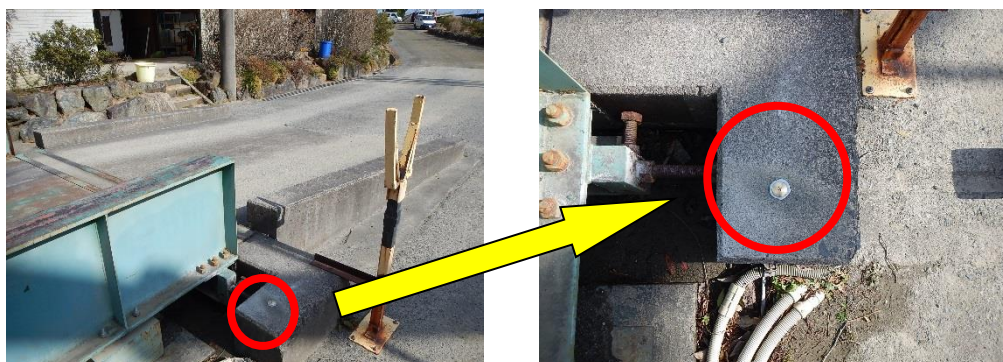
図 3.4-8 三山クリーン(株)産業廃棄物最終処分場における基準点設置状況
