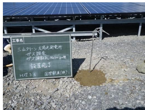
図 3.4-21 保護管 設置
