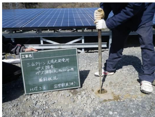
図 3.4-20 ボーリングバーによる掘削
