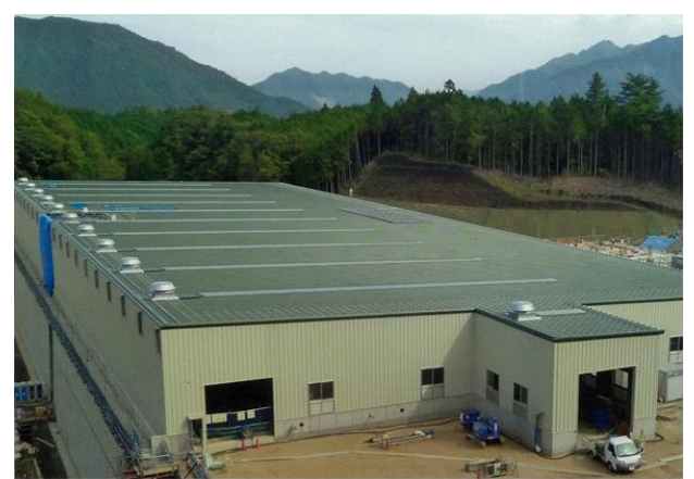
第1期被覆施設写真
