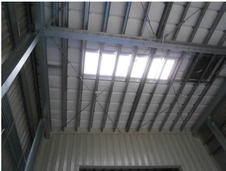
写真-3 被覆施設屋根内部②
