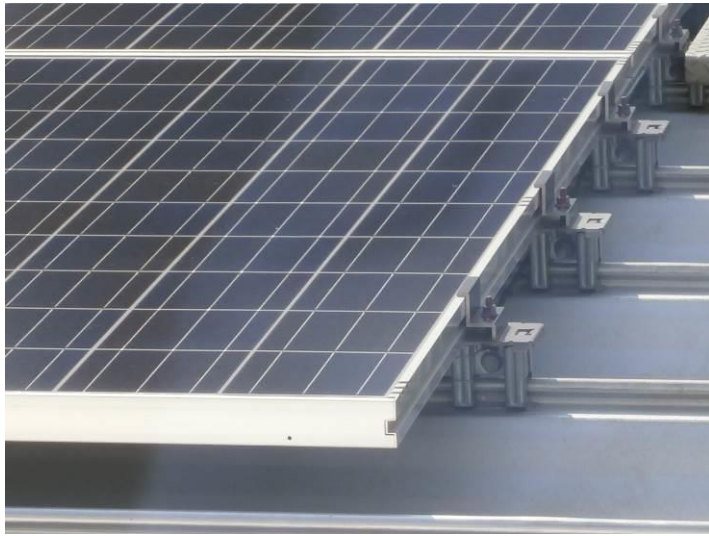
写真-10 撮影：平成 28 年 2 月 26 日 水処理敷設屋根のパネル
