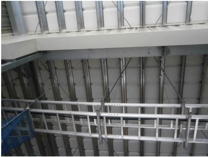
写真-4 被覆施設屋根内部③
