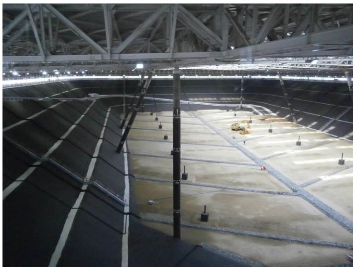
写真-9 撮影：平成 28 年 2 月 26 日 埋立地全景
