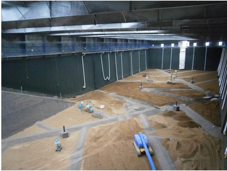
写真-1 埋立地内部
