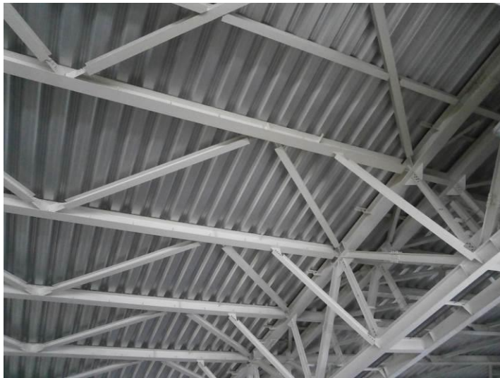
写真-8 撮影：平成 28 年 2 月 26 日 覆蓋施設屋根内部
