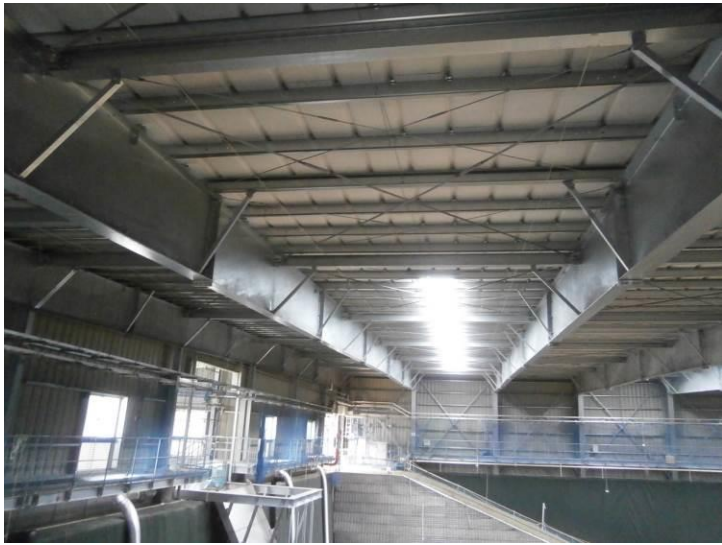
写真-2 被覆施設屋根内部①
