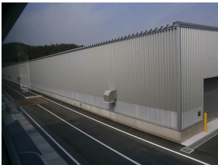
写真-12 撮影：平成 28 年 2 月 26 日 覆蓋施設外壁
