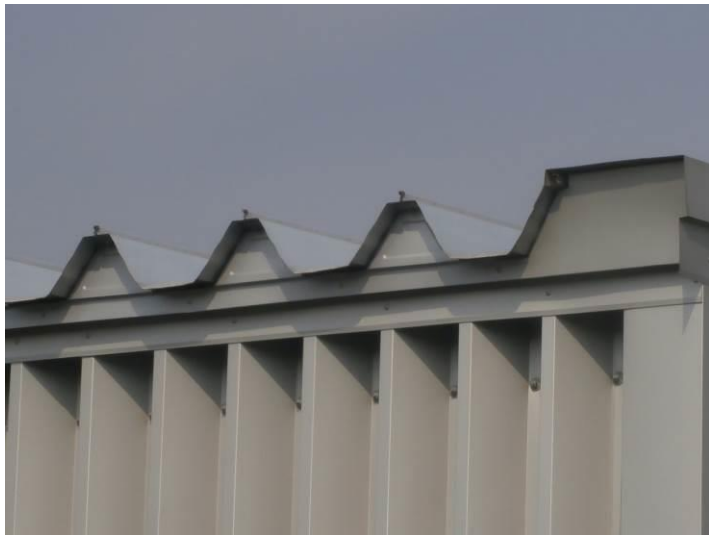
写真-11 撮影：平成 28 年 2 月 26 日 覆蓋施設の折板屋根
