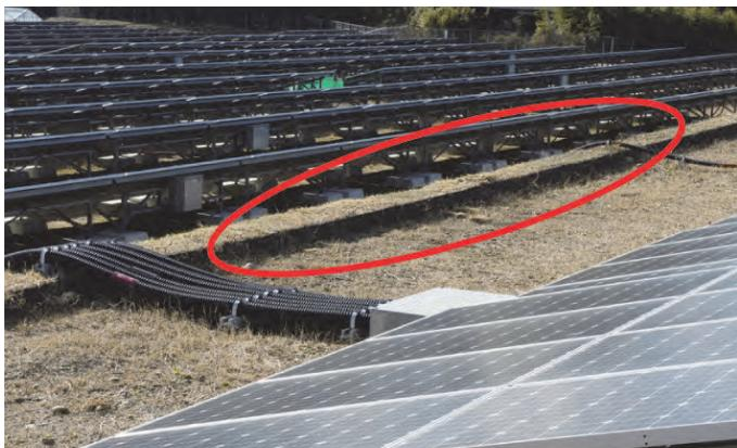
雨水による表土等の流出を防ぐため雑壇ごとに土壌堤を設置
