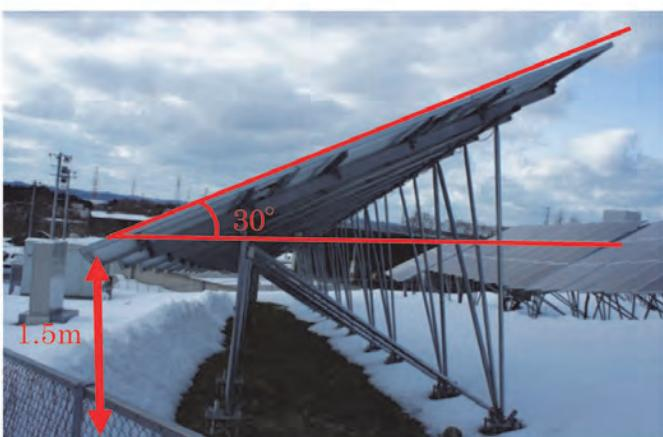
積雪対策としてパネル設置高を最低1.5m、パネル角度を30度で設置
