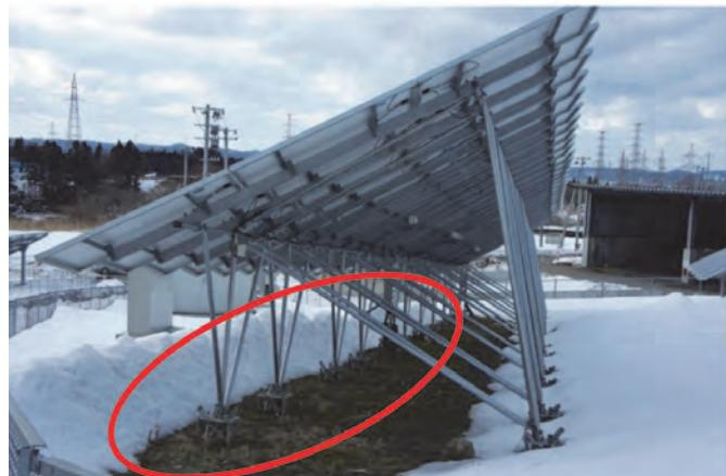
表土流出対策のため雨水が直接当たるパネル下に草丈の低い植物を植栽
