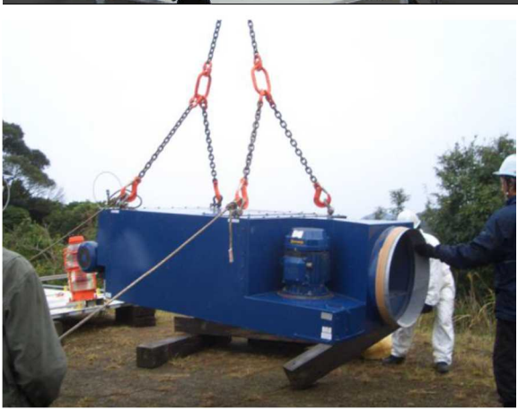
(増速機、発電機の取外し・搬入)
