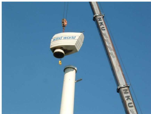
（ナセルの取外し）
