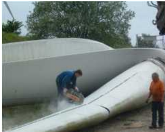
図 3-37 ブレード解体作業の様子
