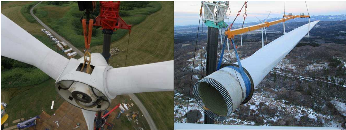
図 3-25 専用治具を用いたローター・ブレードの吊り上げ作業の様子
