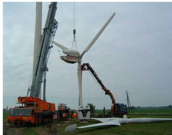
（ローター・ナセルの解体）
