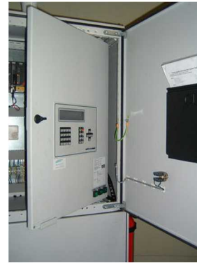
(Vestas 1.65MW 機制御装置)
