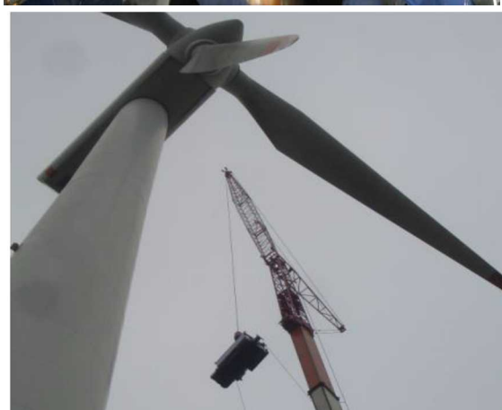
(増速機、発電機の取外し・搬入)
