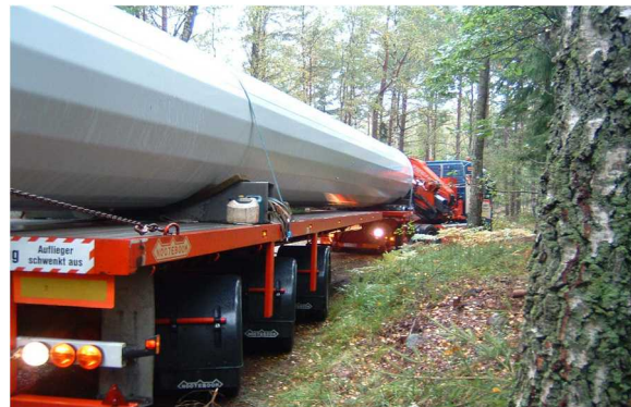
（タワーの解体・運搬）
