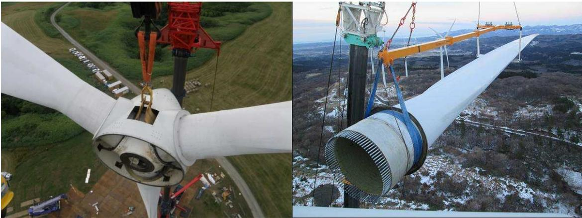
図 3-25 専用治具を用いたローター・ブレードの吊り上げ作業の様子
