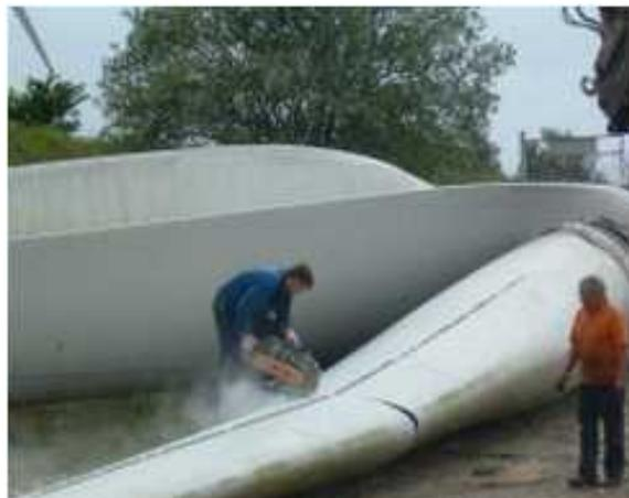
図 3-37 ブレード解体作業の様子
