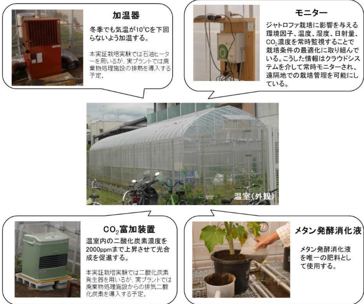
図 45 本事業で構築した実証用温室（令和元年度事業報告書より）
