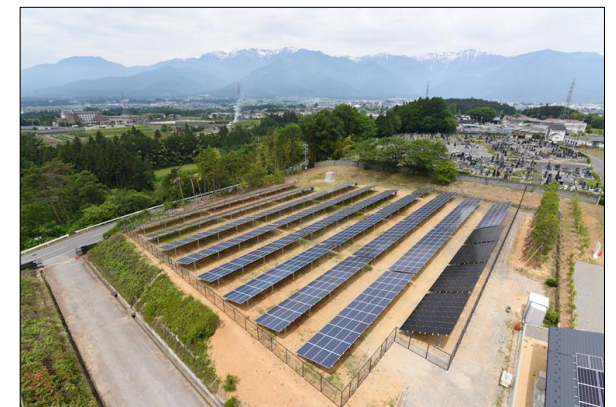
リユース品を使用した発電所
