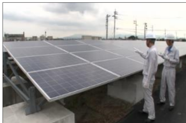
太陽発電設備の検査の様子
