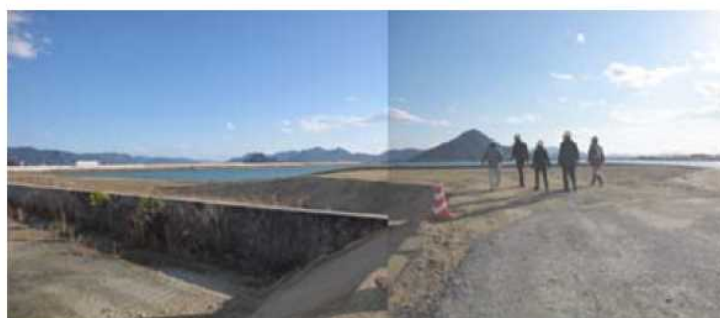
写真 7-5 二次仮置場に隣接する最終処分場（第 3 工区）
