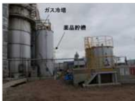
写真 7-6 東日本大震災での仮設焼却設備のマットスラブ工法による基礎の施工事例
