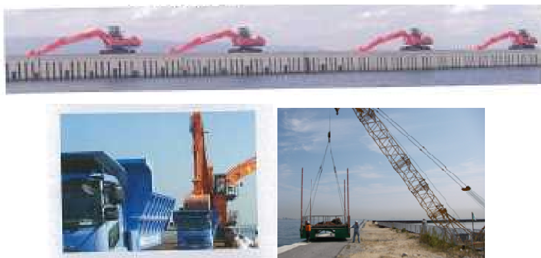
写真 7-7 廃棄物運搬船から荷降ろしをする大型バックホウ（上）と場内運搬用の 11 トンダン プトラック（総重量 20 トン）（左下）、移動式 25 トンラフタークレーンによる作業（右下）
