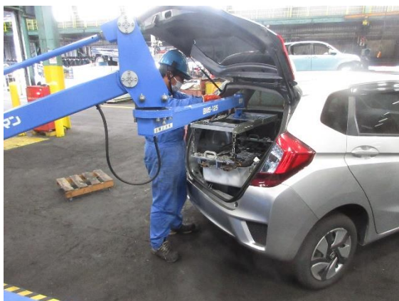
f) LIB ユニットを取り出し
