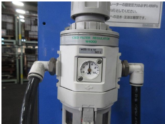
b) 圧力ゲージ指示圧 0.49MPaG を確認
