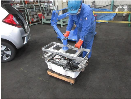
h) LIB ユニットのパレットへの定置
