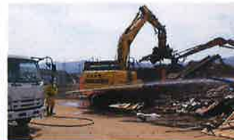
破碎時の散水による粉じん対策
