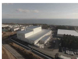
大熊町の仮設焼却施設
