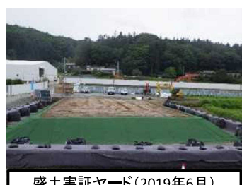
盛土実証ヤード(2019年6月)
