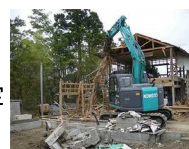
被災家屋等の解体
