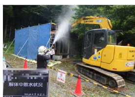
被災家屋等の解体の様子
