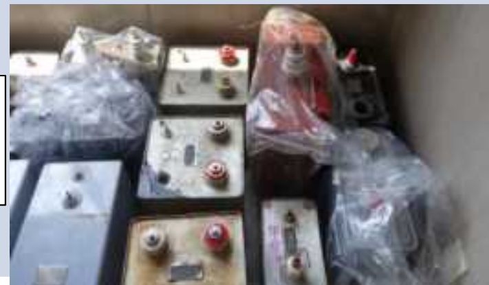
保管庫内に収納したコンデンサー（漏えい機器はポリ袋に収納）
