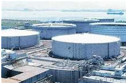
石油貯蔵タンク
