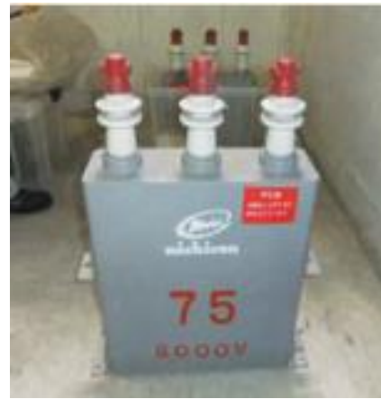
電力用コンデンサー
