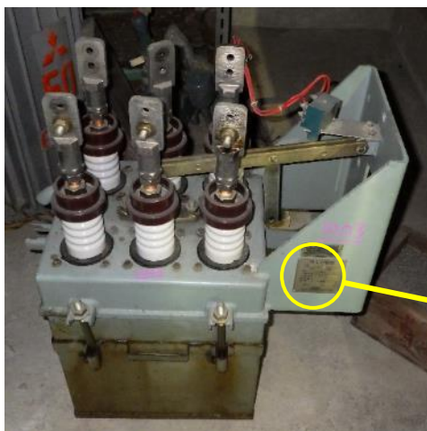
遮断器 (油入遮断器)
