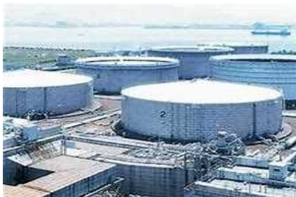
石油貯蔵タンク
