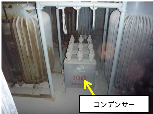
コンデンサー（周辺の変圧器は使用中）
