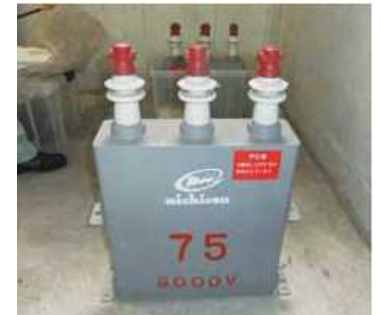
電力用コンデンサー
