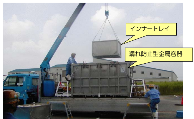
漏れ防止型金属容器へのインナートレイの積み込み
