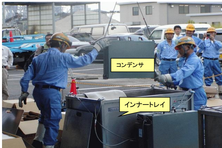
インナートレイへのコンデンサの積み込み
