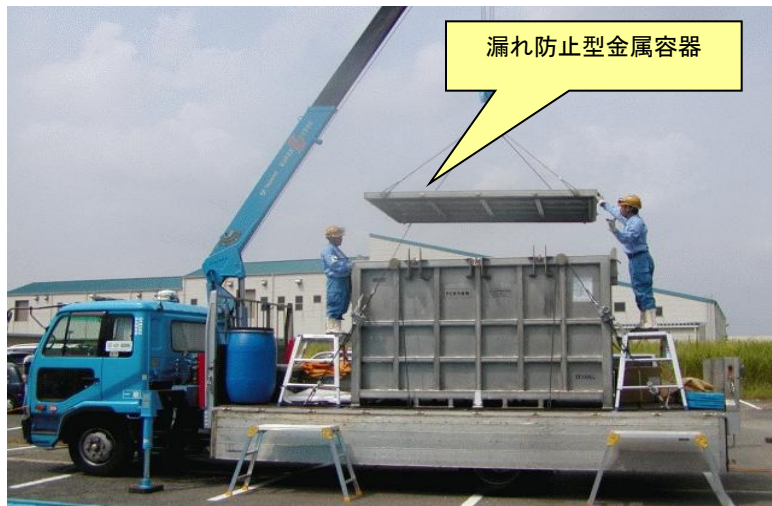
漏れ防止型金属容器の蓋載せ
