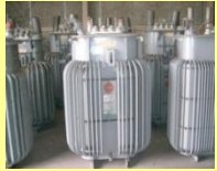
高圧トランス
