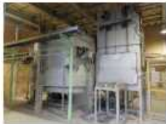
<Li-ion電池リサイクル設備>
