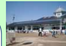
市民出資による 太陽光パネル設置
