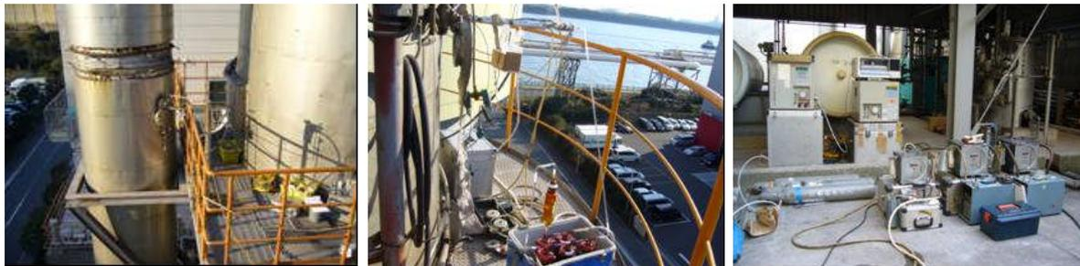
排ガス採取(左：BF 入口、中：煙突)
