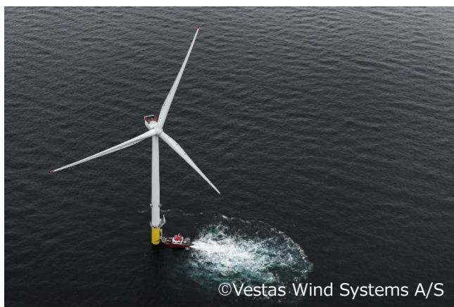
（写真）着床式洋上風力発電施設（日本風力発電協会提供）
