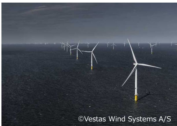
（写真）着床式洋上風力発電施設（日本風力発電協会提供）
