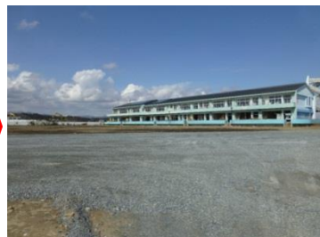
撤去後(平成27年3月)
