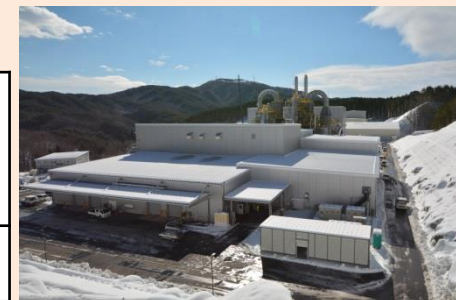
飯舘村蕨平地区の仮設焼却施設 (平成28年1月)
