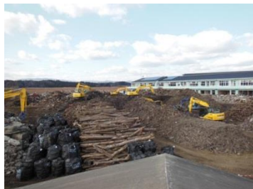
撤去前(平成26年1月)
