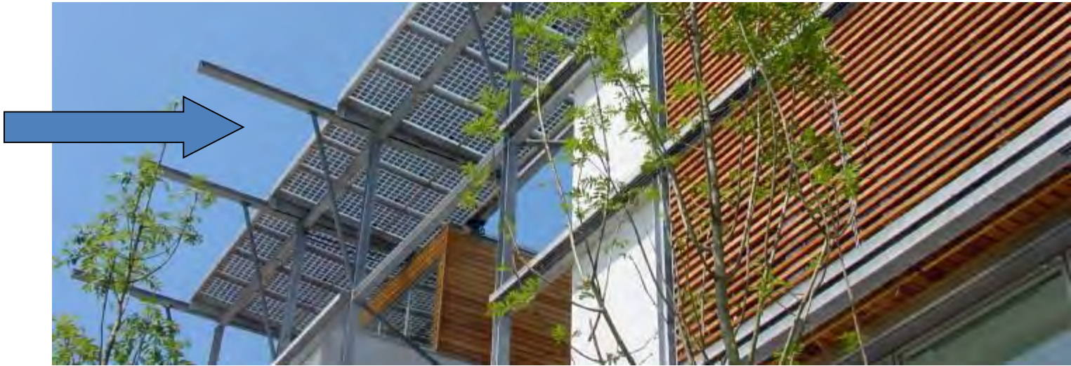
日射確度で伸縮するパネル(上)、「ひさし」になる太陽光パネル(左下)、 パネルで室内への日射を抑える(右下)。
