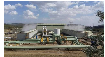
円借款により導入された地熱発電所(ケニア・オルカリア)
