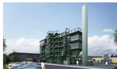
ミャンマー グレーターヤンゴンにおける廃棄物発電事業
