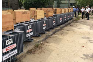
【高効率アモルファス変圧器】 （ベトナム） 無負荷損失が大幅に低減する変圧器を南部・中部の配電網に導入。想定削減量4,360tCO 2 /年。2017年2月稼働予定。
