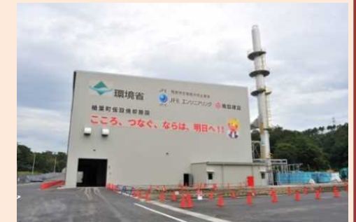
檜葉町の仮設焼却施設(平成28年10月)
