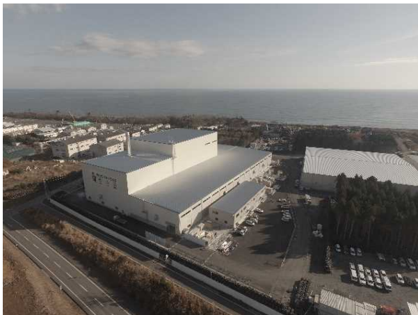
大熊町の仮設焼却施設(平成29年12月)
