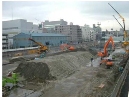
場内掘削残土の再利用
