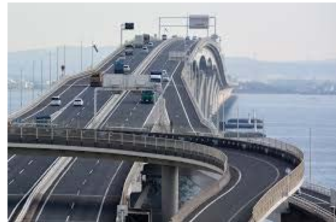
高速道路（道路、橋梁）
