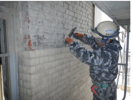
外壁タイルの活かし取り
