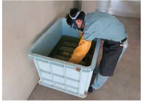
タイル裏モルタル除去
