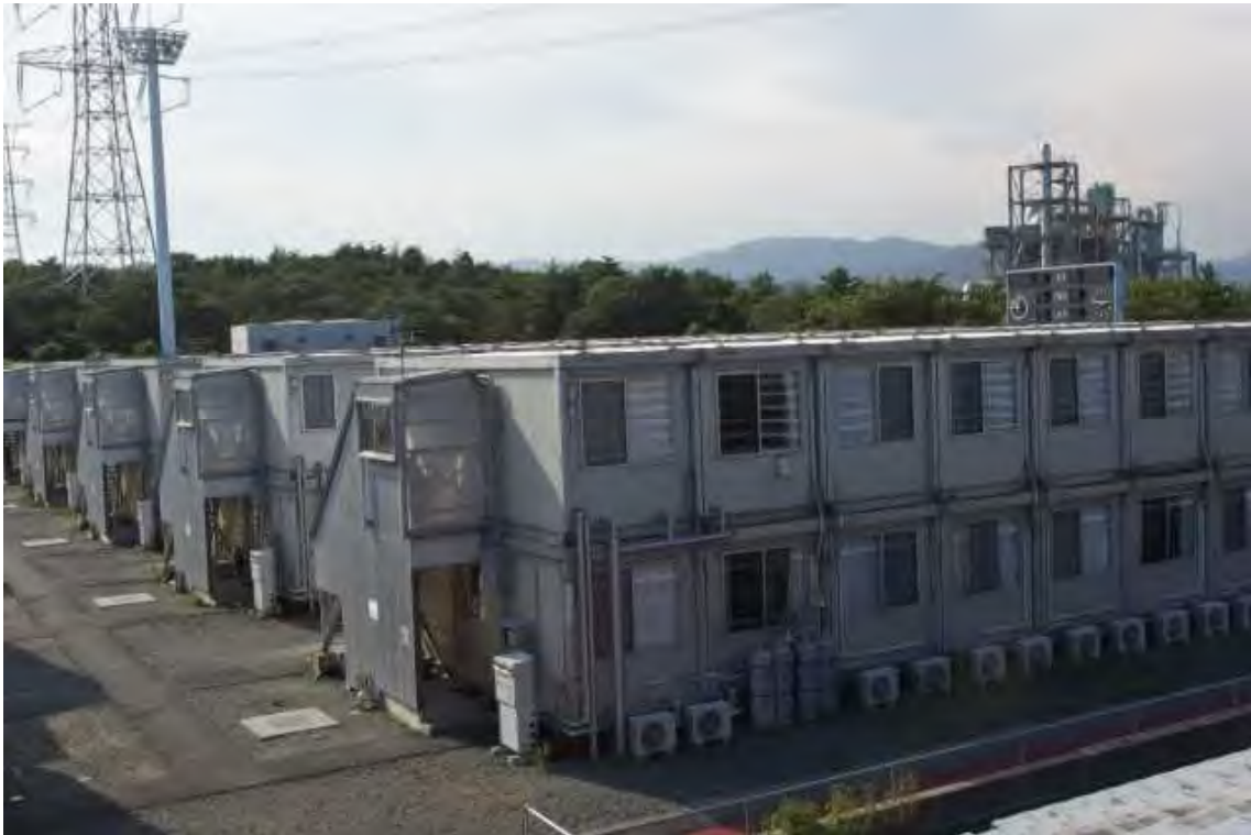
(写真1：周辺の状況1)
