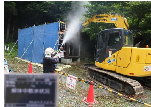
被災家屋等の解体の様子
