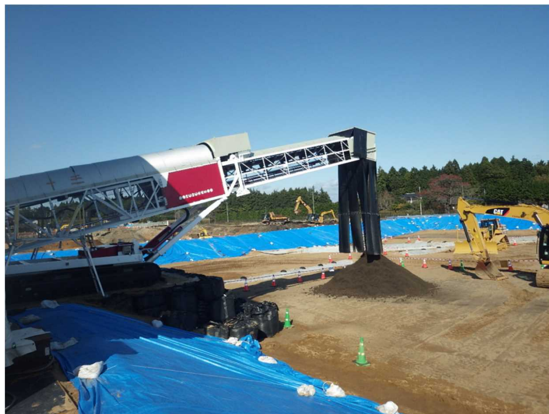
土壌貯蔵施設(1期大熊工区) (計画貯蔵容量 約21万m 3 )
