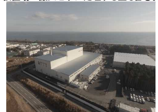
大熊町の仮設焼却施設
