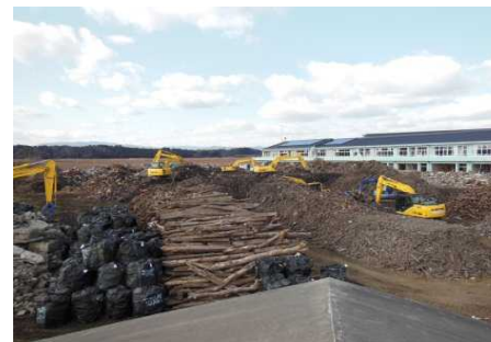
撤去前(平成26年1月)
