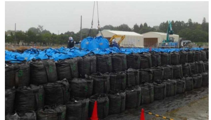
保管場への定置作業
