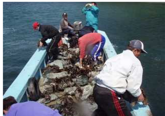
アラメ付自然石の投入作業
