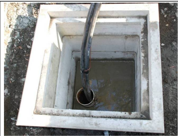
先端閉塞の回転貫入鋼管杭の頭部にコンクリート製柵を設置し、鋼管杭内部に循環水パイプ (ポリエチレン製) を挿入
