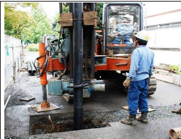
先端閉塞の回転貫入鋼管杭 (Φ165.2) の施工状況 (GL-30m まで設置)
