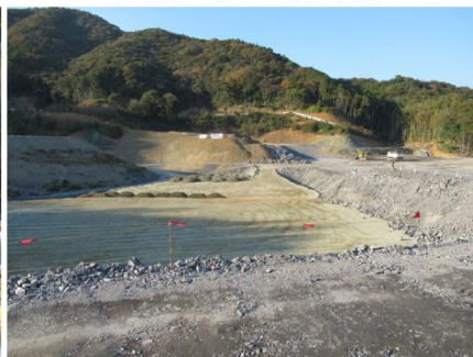
自然由来等土壌の埋立状況（処理）
