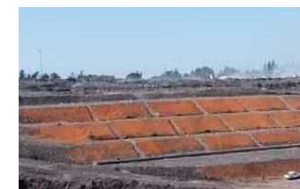
処分場改善 (福岡方式)
