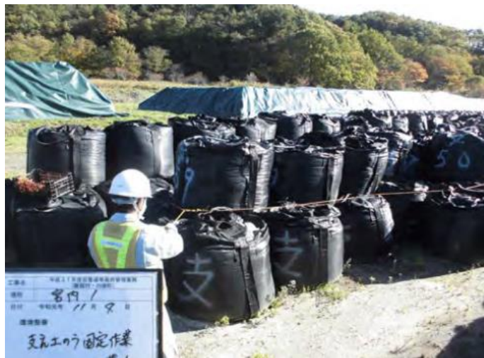
事前措置の例1: 搬出作業中の保管物をロープにより連結・固定し、流出防止を図る。
