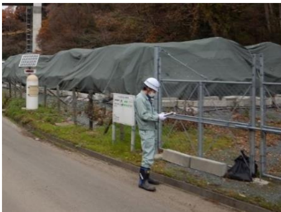
目視点検の例: 日常点検において、外観上の異常を確認する。
