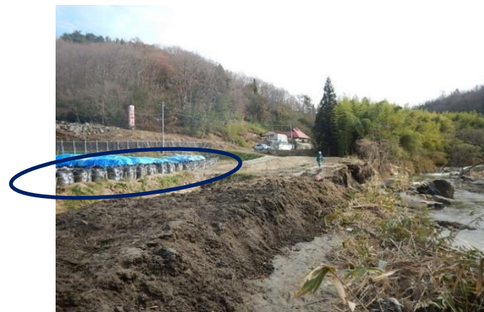
搬出や移設が困難な場合の対策例2: 仮置場で使用していた遮へい土のうを活用し、土のうを用いた堤防を設置して、氾濫した流水の減勢を行う
