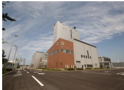
秋田県木質バイオマス発電事業
