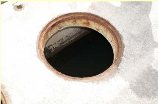
写真1 蓋が破損した浄化槽
