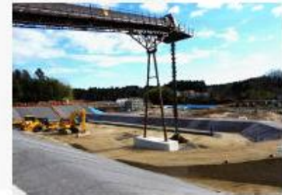
土壌貯蔵施設（双葉工区）
