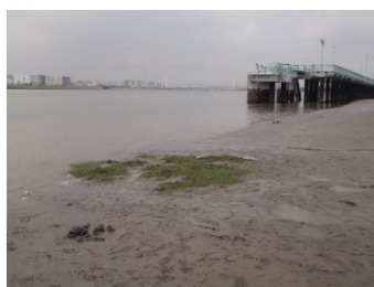
写真 8 写真 H28. 8. 3 の全景
