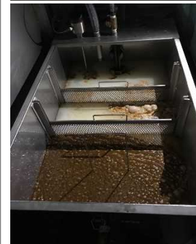
← 導入した排ガス処理装置により分離回収された大量の油分
