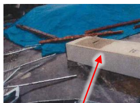
建物解体時に回収作業が行われず、放置されている業務用エアコン
