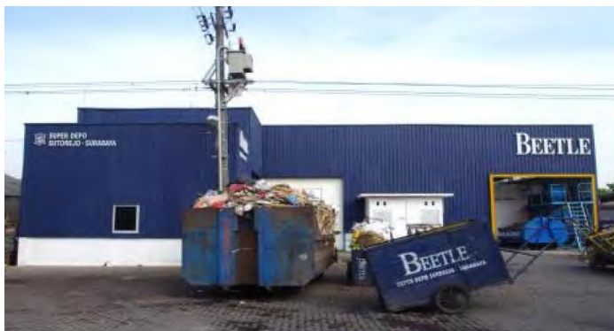
中間処理施設
