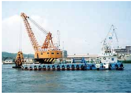
図-3.1 浚渫作業状況（例）
