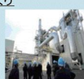
バイオマス発電所
